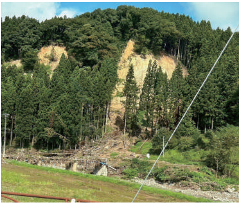
山肌が崩落し、橋も損壊していました (2024年9月18日、酒田市青沢地区)
